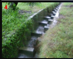
5條坡地 縱向排水
