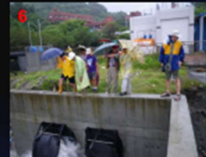
海水倒灌 積砂，抽水 站排水 (4CMS)
