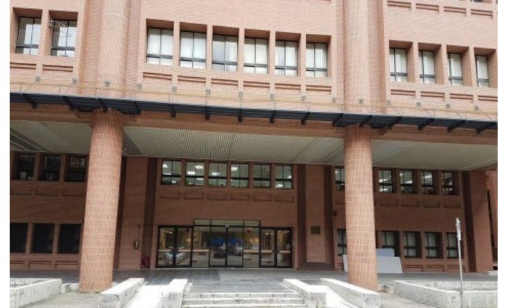
圖資大樓後廊
