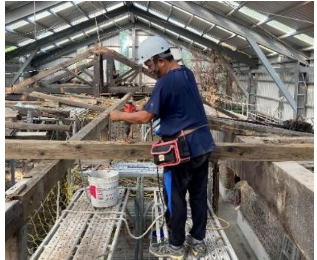
▲屋架整修工程-拆除、仿作抽換、整修
