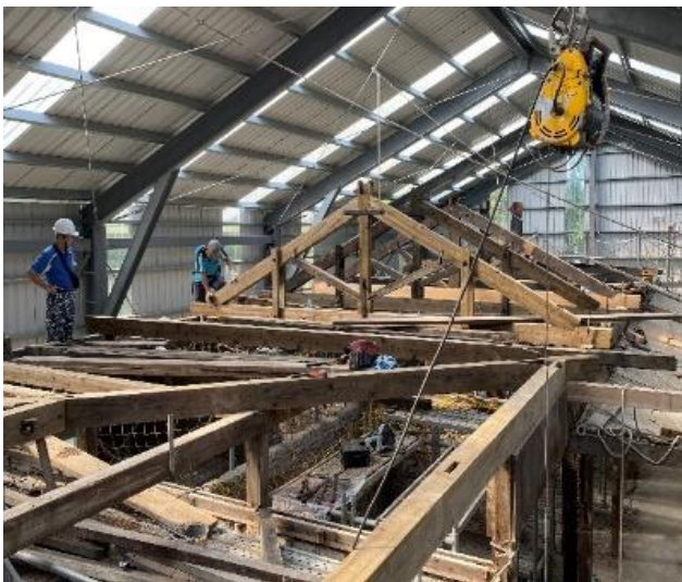
▲屋架整修工程-拆除、仿作抽換、整修
