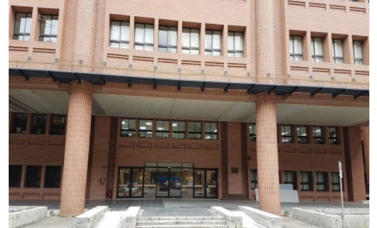
圖資大樓後廊
