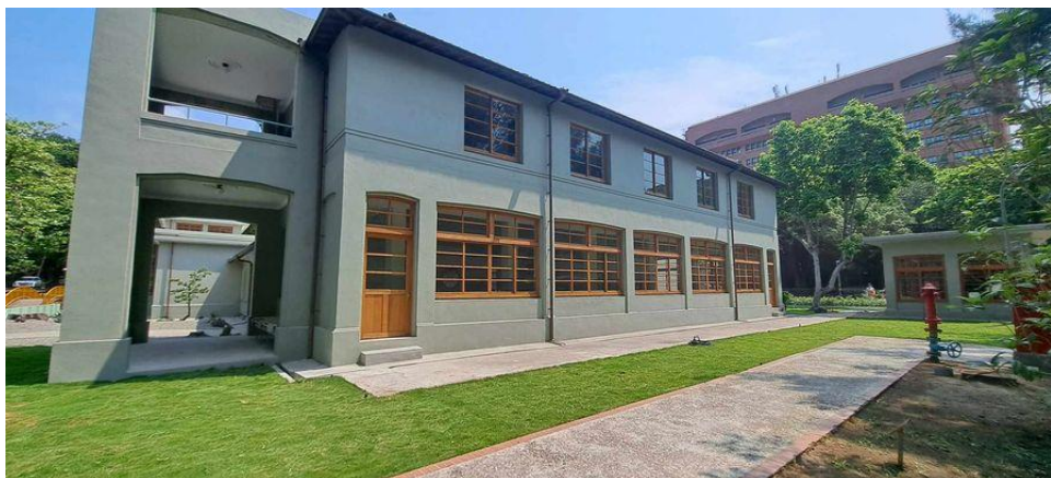
▲修復後-建築外貌
