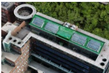
海工館屋頂21kWp(躉售)
