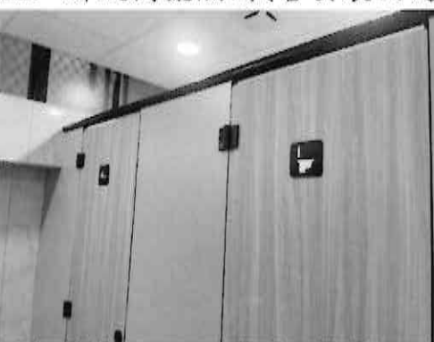
12. 新設搗擺隔間(含安裝固定)
