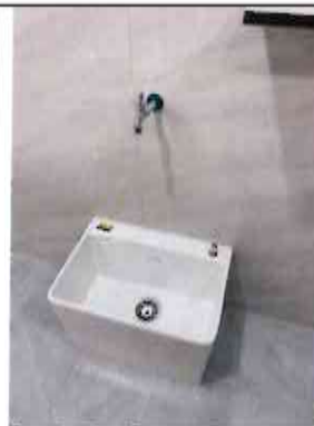
10. 新設搗擺隔間(含安裝固定)
