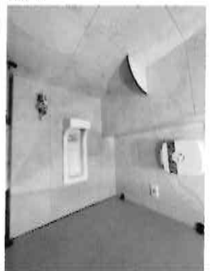
9. 馬槽型人造石洗手台(下方安裝水龍頭)及自動龍頭
