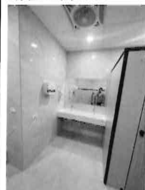
11. 新設搗擺隔間(含安裝固定)
