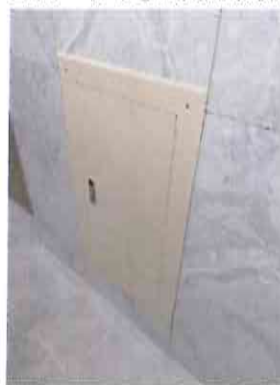
22. 管道間蓋板更新(塑鋼門)
