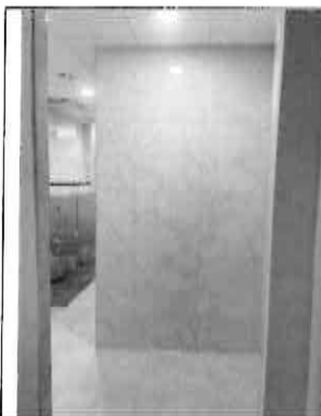
5. 地坪水泥砂漿打底抵石子
