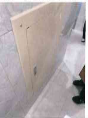
頂樓給水閥更新
