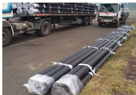
管材進場吊放
