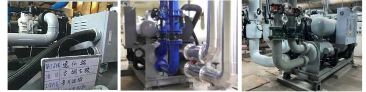
106年逸仙館/體育館/圖資大樓
