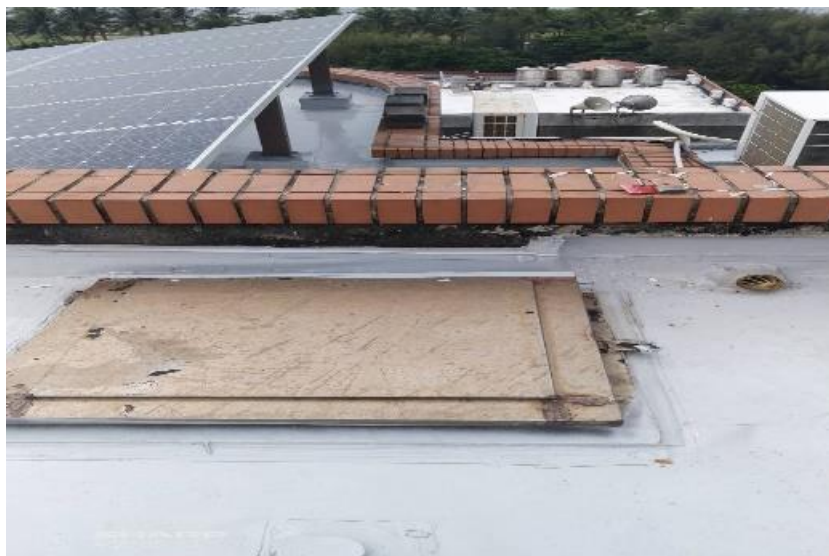
行政大樓頂樓水塔
