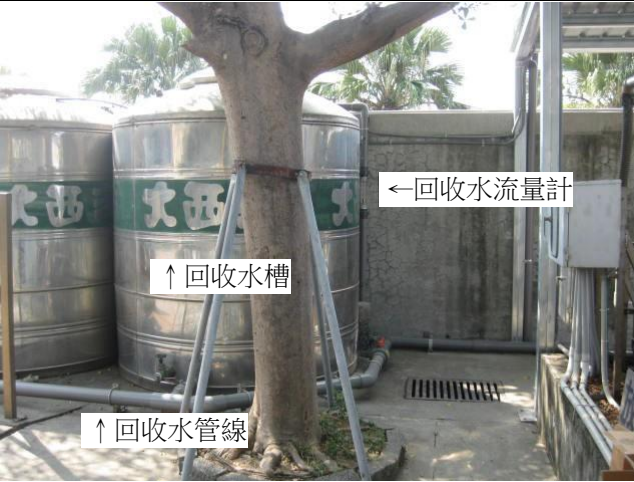
照片 27：回收水進流水流量顯示器
