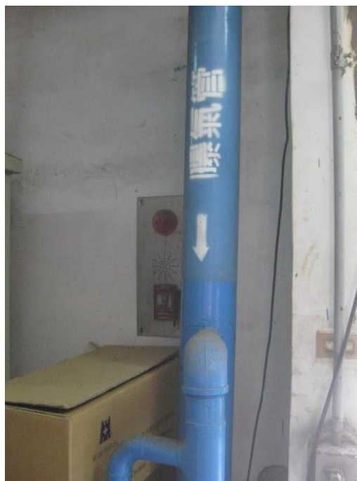
照片 12：鼓風機組之曝氣管線
