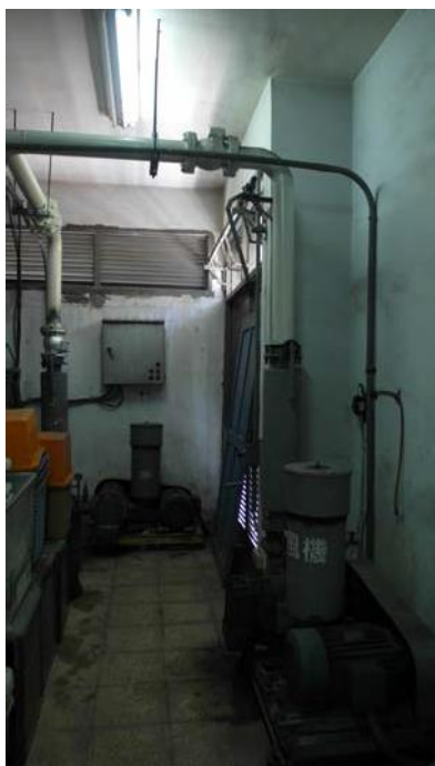
照片 11：曝氣槽與污泥濃縮槽共用之鼓風機組
