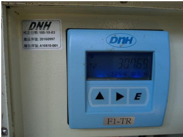
照片 28：回收水進流水流量顯示器近照
