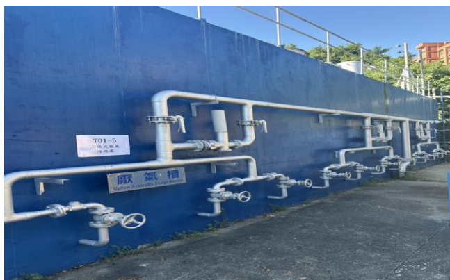
照片 11：曝氣槽與污泥濃縮槽共用之鼓風機組
