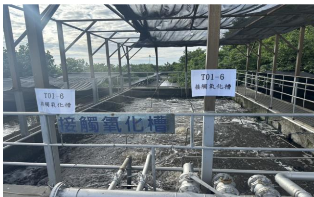
照片 12：鼓風機組之曝氣管線
