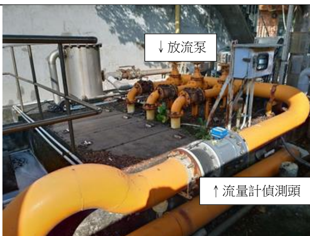
照片 18：放流槽及放流泵、流量計
