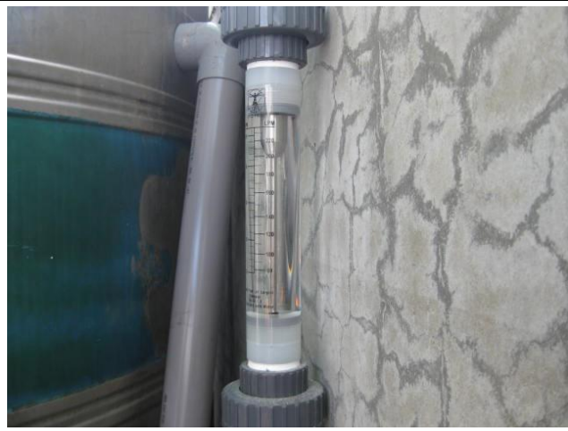
照片 28：回收水進流水流量顯示器近照
