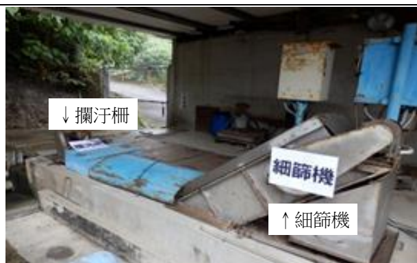
照片 5：T01-1 攔污柵與 T01-2 細篩機
