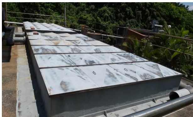
照片 10：T01-6 接觸氧化槽
