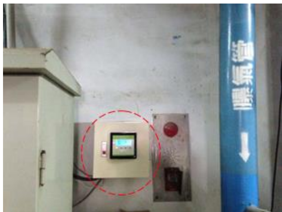
照片 3：廢水處理-專用獨立電表 2 (廢水處理廠整廠專用，除專用獨立電表 1 外)
