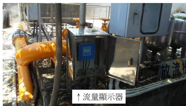
照片 20：放流水流量顯示器
