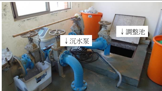
照片 9：T01-5 上流式厭氣污泥床管線
