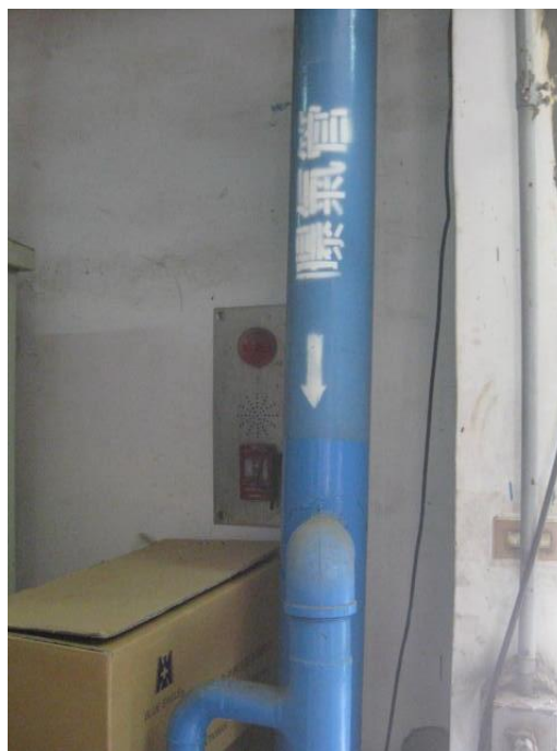
照片 12：鼓風機組之曝氣管線
