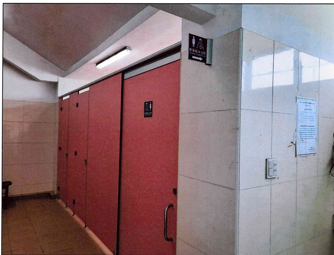
照片(13)、網球場女淋浴更衣室淋浴間新設無障礙廁所橫拉門(含五金配件)
