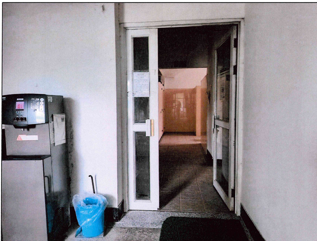
照片(11)、網球場男淋浴更衣室淋浴間入口門檻處斜坡順平
