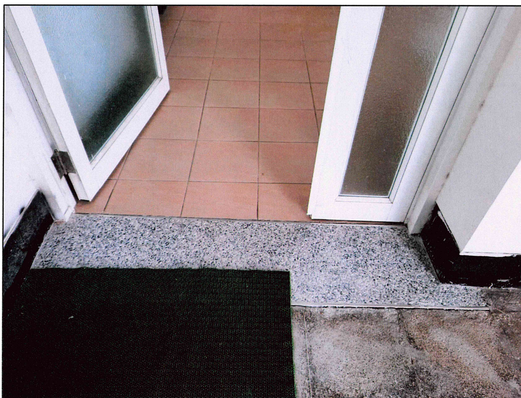
照片(14)、網球場女淋浴更衣室淋浴間入口門檻處斜坡順平
