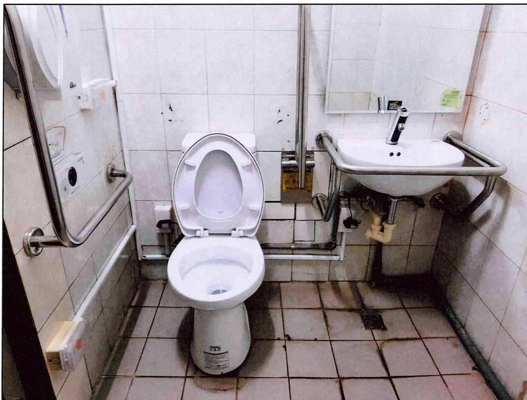
照片(1)、文學院大樓 3F 東側無障礙兼性別友善廁所新設社服用坐式自動 沖水馬桶及扶手含配件
