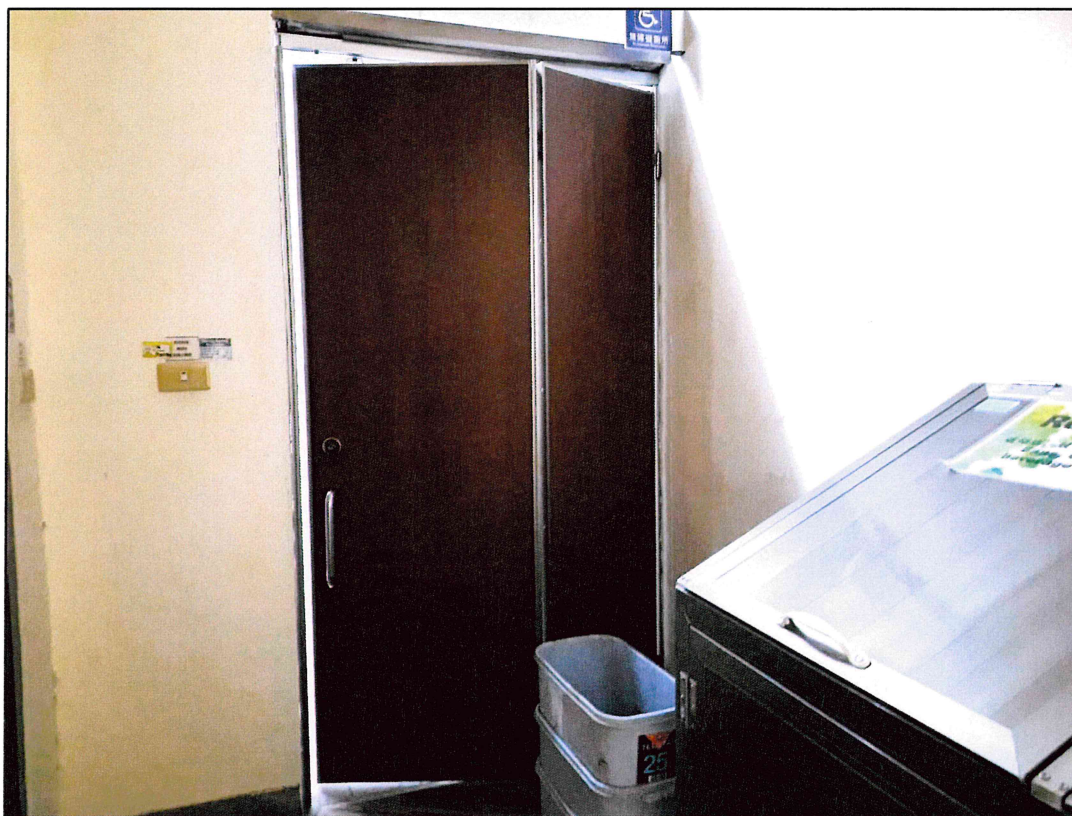
照片(3)、文學院大樓 3F 東側無障礙兼性別友善廁所橫拉門(含五金配件全)
